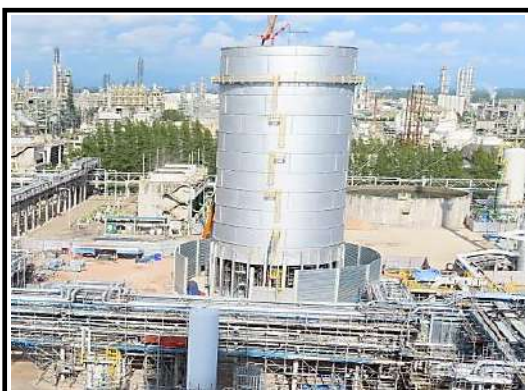
รูปที่ 7 งานก่อสร้างหอเผา (Ground Flare)
