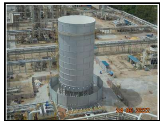
รูปที่ 7 งานก่อสร้างหอเผา (Ground Flare)
