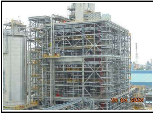
รูปที่ 2 งานติดตั้งโครงสร้างเหล็ก (Erection Structure work)
