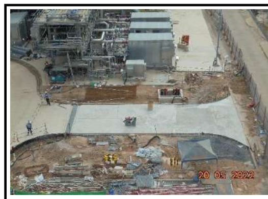
รูปที่ 1 งานปรับพื้นและงานทำถนน (Paving work)
